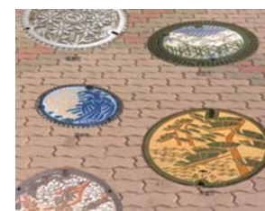
グラウンドマンホール
